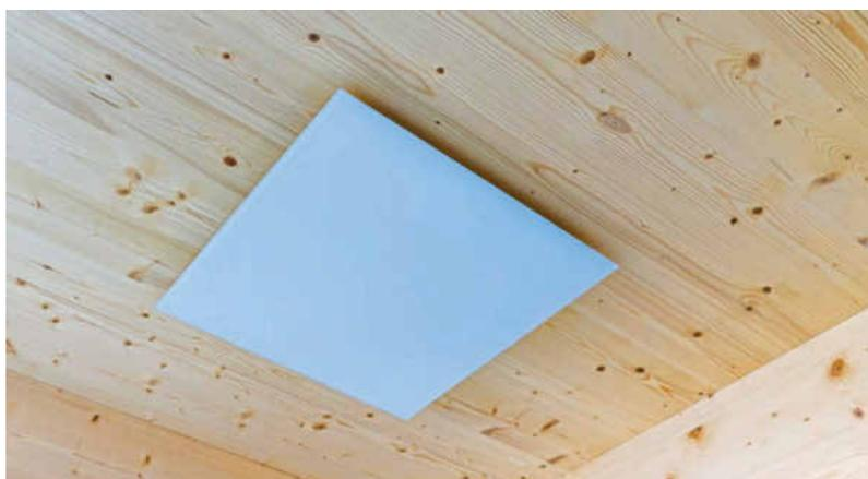
Die rahmenlosen Heizelemente – hier mit satiniertes Glasoberfläche – liefern angenehme Strahlungswärme.
